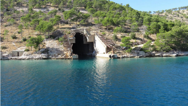
Gut versteckter U-Boot-Bunker in einer Bucht ...
